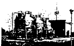
Рис. 10.7. Водозаборно-очистной узел с фильтрами ФПЗ-3,4-150 для крупномасштабной системы капельного орошения садов в Молдове
